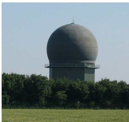
Figuur 16: De MPR gevechtsleidingsradar bij Wier. Rechts de feitelijke radar in de radome.
