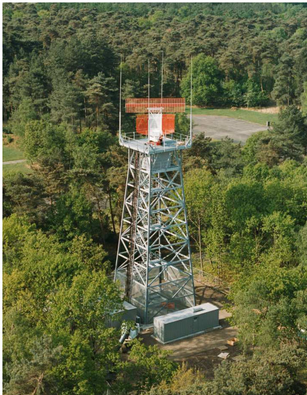
Figuur 3: Een foto van één van de MASS verkeersleidingsradars met onderaan de antenne van de primaire radar en daarbovenop het antenneraam van de secundaire radar. Het geheel draait rond.
