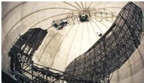
Figuur 16: De MPR gevechtsleidingsradar bij Wier. Rechts de feitelijke radar in de radome.
